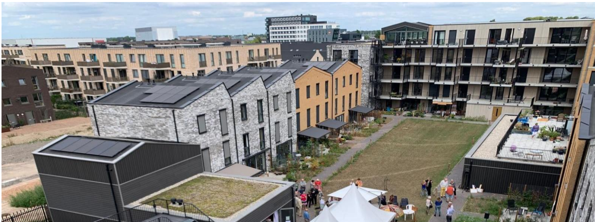
Sfeerimpressie van een eerder Energiemarke-project
